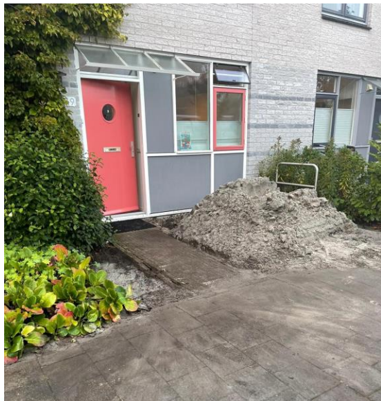
Boren in een bestaande situatie
