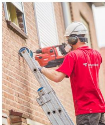
Boorgaten aanbrengen
